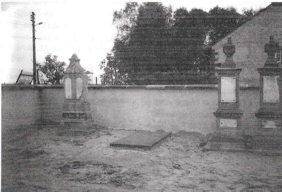
Etat des mêmes lieux après interventions.
