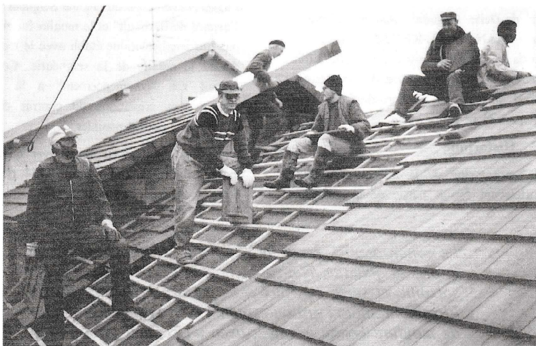
La nouvelle chapelle de Florimont - Delle en construction (en haut) ... et le résultat (en bas).
